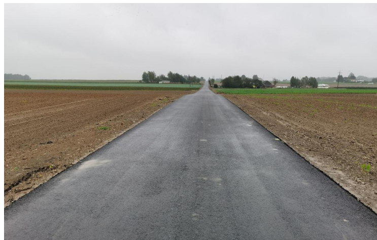
14. Przebudowa drogi gminnej nr 107089L w m. Strzeszkowice.
