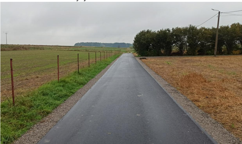
13. Droga Sobieszczany o dł. ok. 550 m - inwestycja sfinansowana ze środków FOGR.
